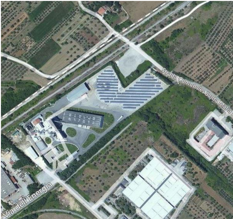
Figura 2 Vista area del sito impiantistico
